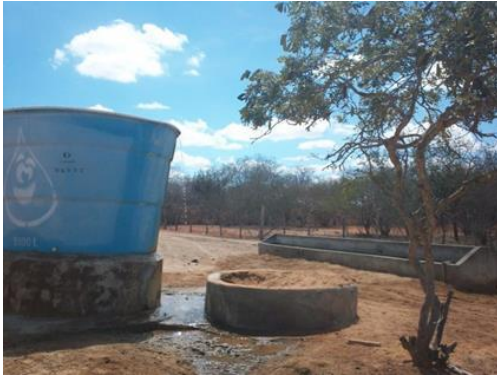
Figura 1. Água extravasando da caixa d'água.
