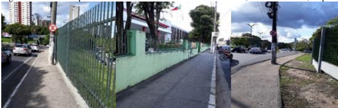
Figura 1. Trecho dos passeios de acesso às universidades EST/UEA, IFAM e UFAM, respectivamente.
