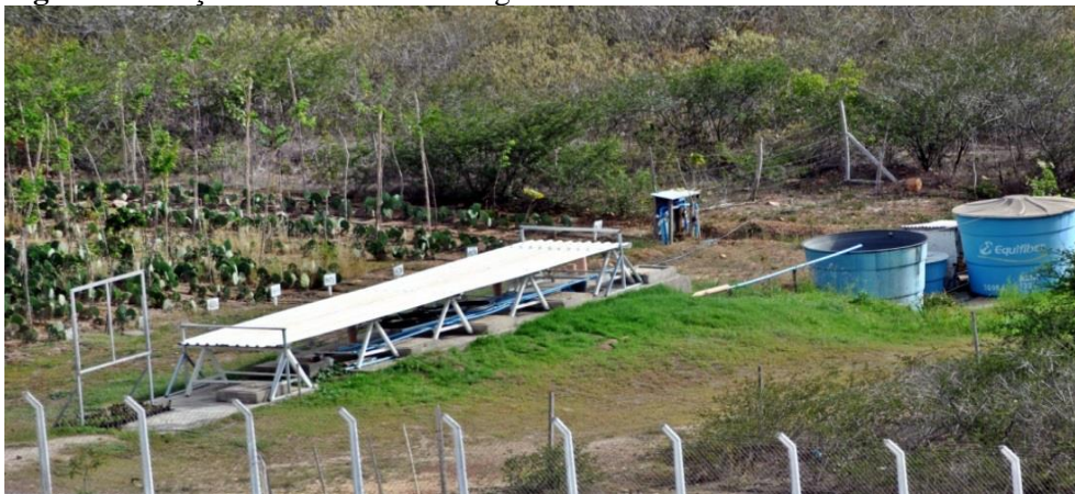
Figura 1. Estação de tratamento de esgoto doméstico da sede do INSA.
