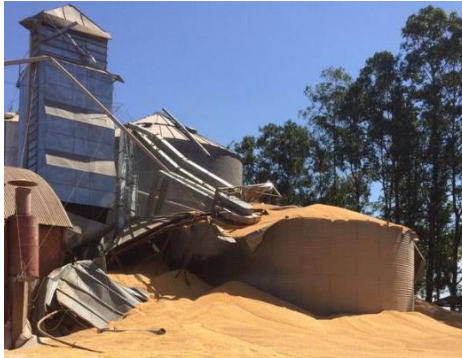
Figura 4. Silo rompido em Mato Grosso. Fonte Canal Rural, 2016.
