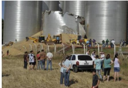
Figura 3. Destroços do silo que se rompeu em RS. Fonte Portal UOL, 2011.
