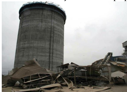
Figura 2. Silo em Paranaguá – PR. Fonte Portal G1, 2007.
