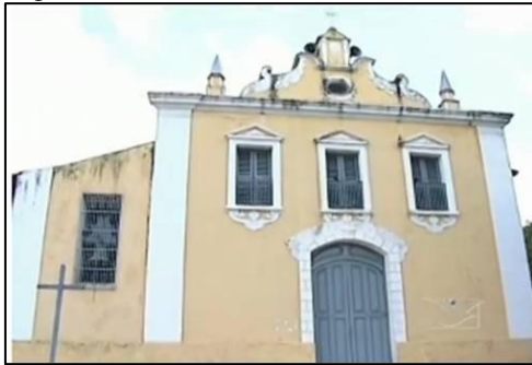
Figura 1. Fachada com manchas de umidade
