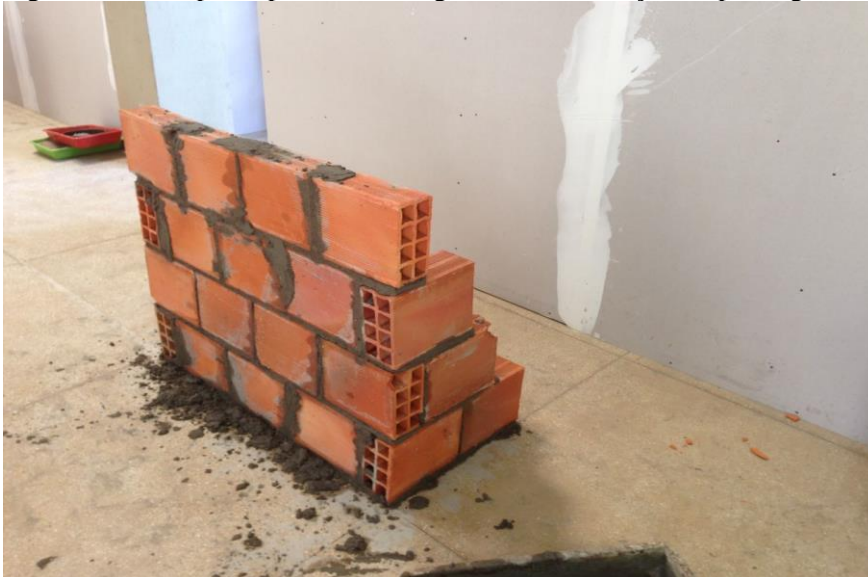
Figura 1. Protótipo de parede com argamassa com adição de pó de gesso
