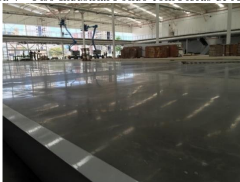
Figura 4 – Piso Industrial Polido com Fibras de Aço
