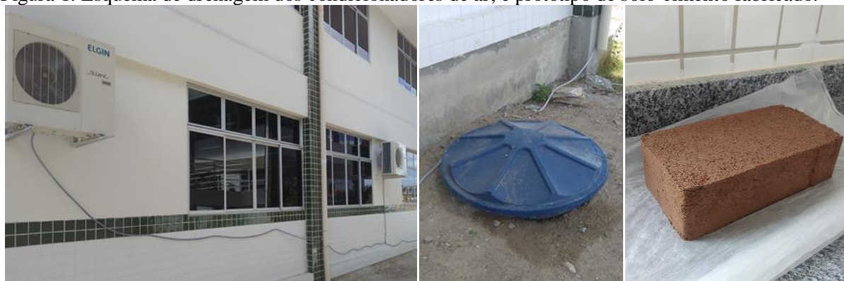
Figura 1. Esquema de drenagem dos condicionadores de ar, e protótipo de solo-cimento fabricado.
