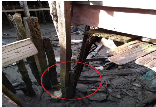
Figura 3 - Vinculação de estacas
