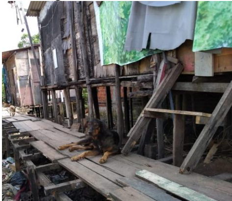
Figura 1 - Paredes de tábuas
