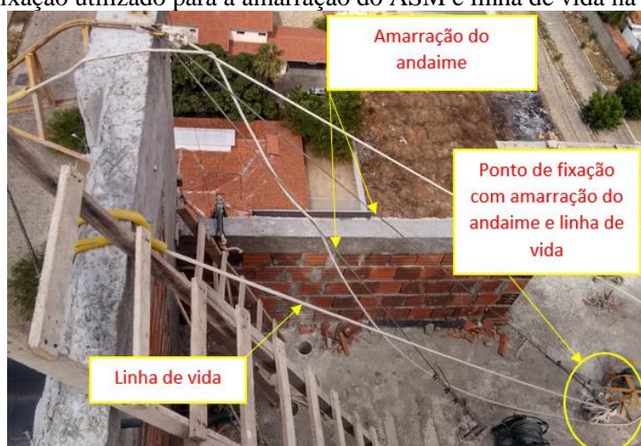
Figura 3. Ponto de fixação utilizado para a amarração do ASM e linha de vida na empresa 1.
