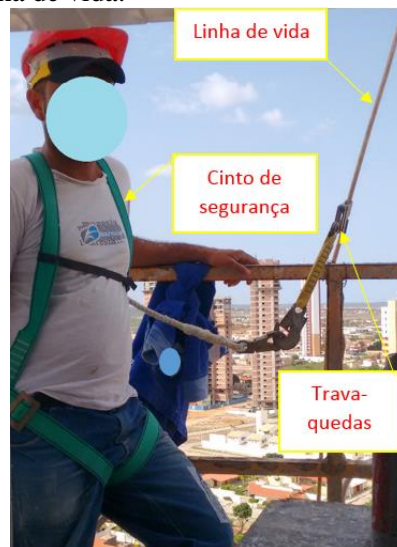
Figura 1. Trabalhador da empresa 2 utilizando cinto de segurança em bom estado de conservação conectado pelo trava-quadras à linha de vida.
