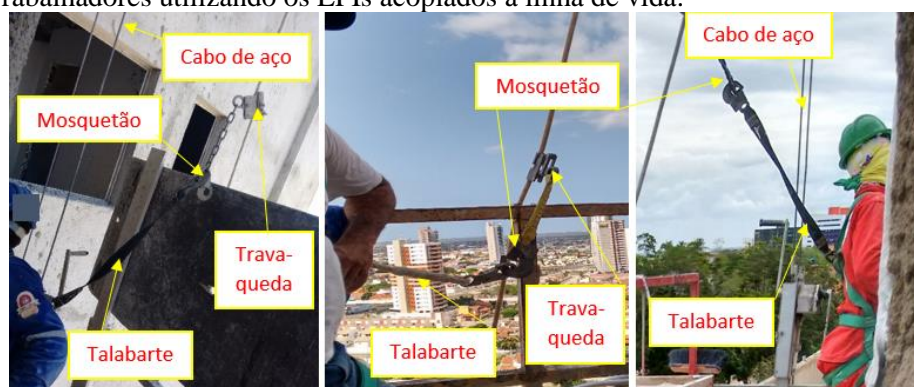
Figura 2. Trabalhadores utilizando os EPIs acoplados à linha de vida.
