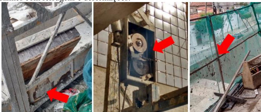
Figura 1. Andaimes com ferrugens e deformações.
