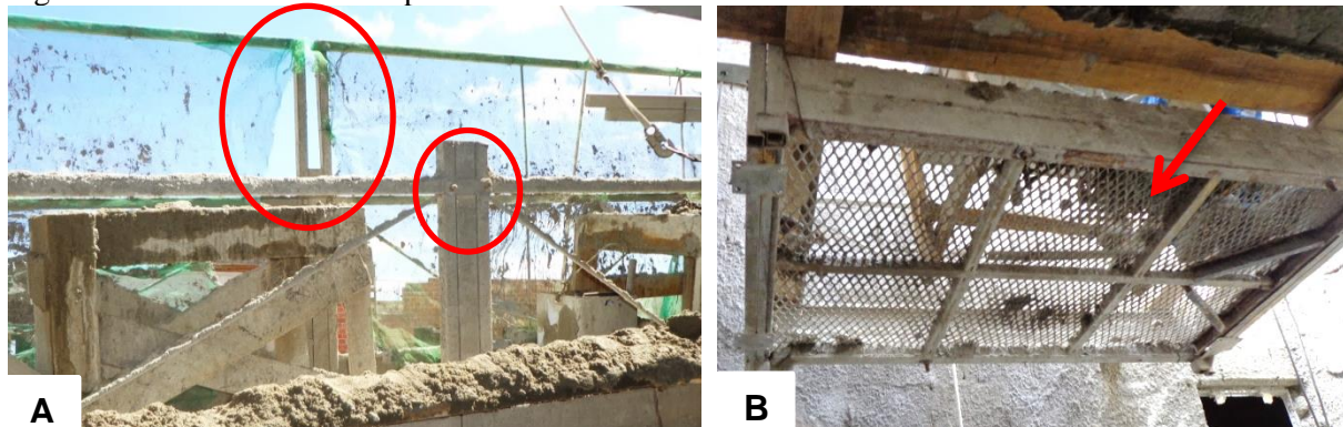
Figura 2. Piso de andaime suspenso utilizado na obra analisada.
