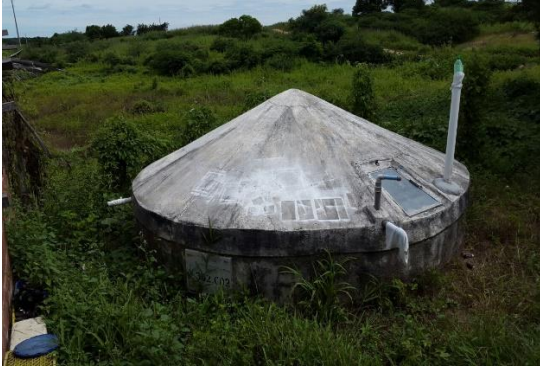
Imagem 1. Vista externa da cisterna analisada
