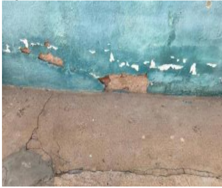
Figura 7. Pintura descascada
