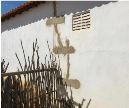
Figura 8. Reparo em instalação hidráulica
