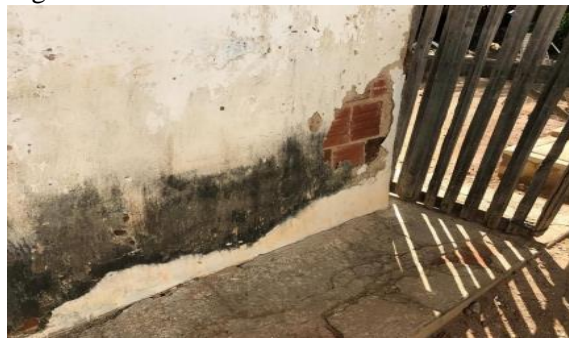
Figura 6. Revestimento solto
