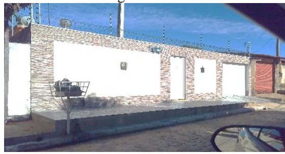
Figura 4. Presença de mobiliário que reduz a largura efetiva
