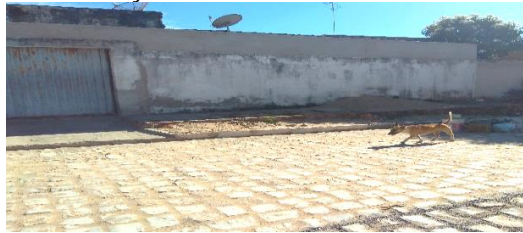
Figura 5. Presença de entulhos acumulados nas calçadas
