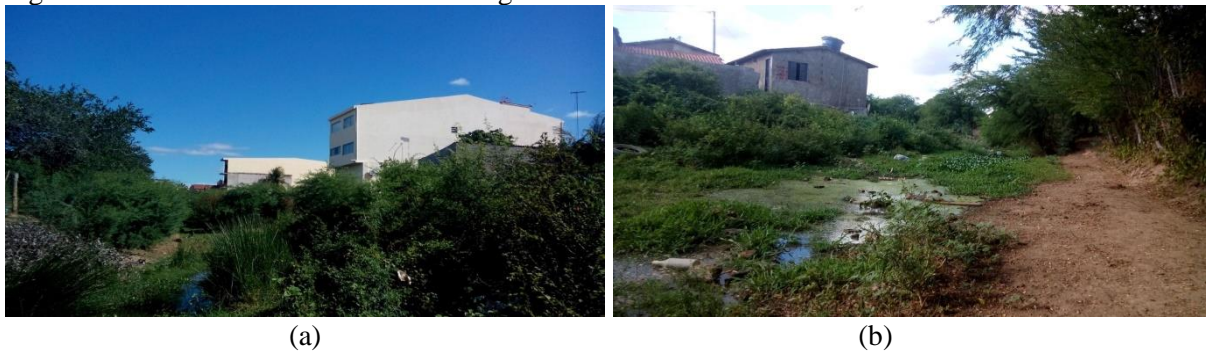
Figura 5 – Residências localizadas na margem do rio
