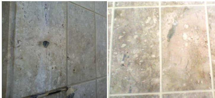
Figura 2: Furo na pedra preenchido com adesivo epóxi e após finalização com cobertura do furo.
