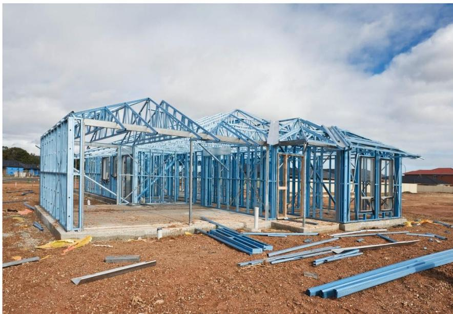
Figura 15. Construção em Steel frame.
