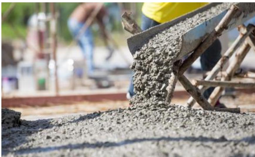
Figura 19. Laje sendo concretada com concreto reciclado.
