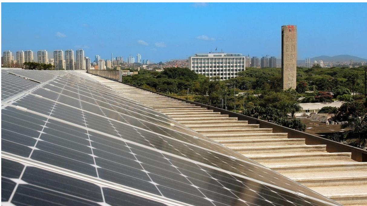
Figura 24. Painéis fotovoltaicos instaladas na cobertura de um prédio.
