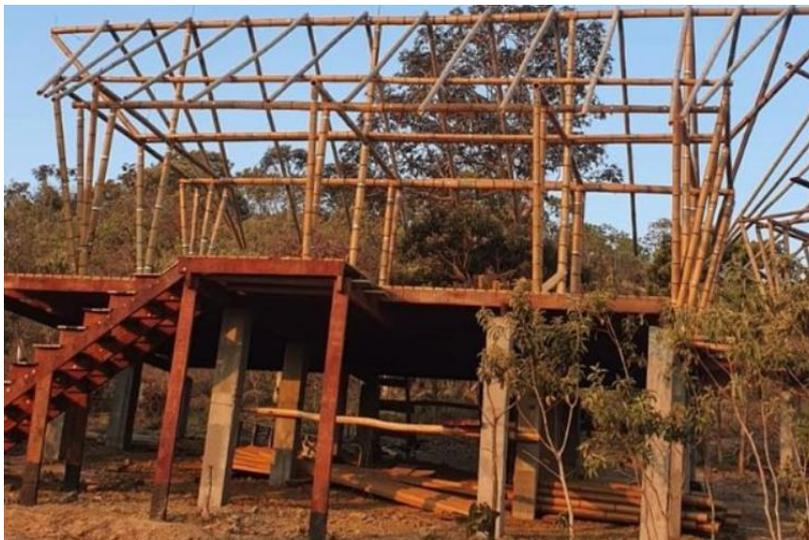
Figura 20. Uso de bambu na construção civil.
