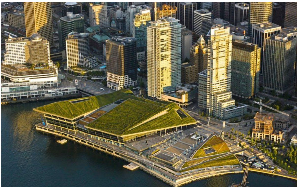
Figura 27. Uso de cobertura verde no Centro de Convenções em Vancouver, Canadá.
