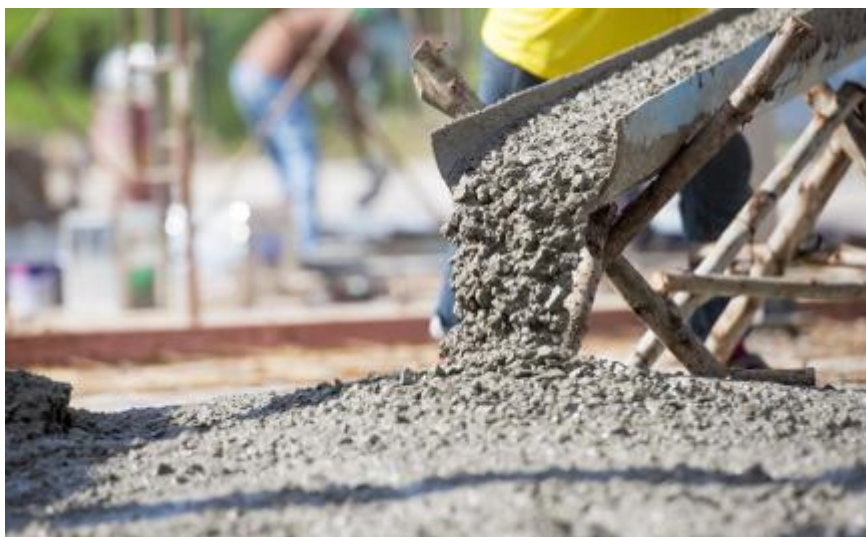
Figura 19. Laje sendo concretada com concreto reciclado.
