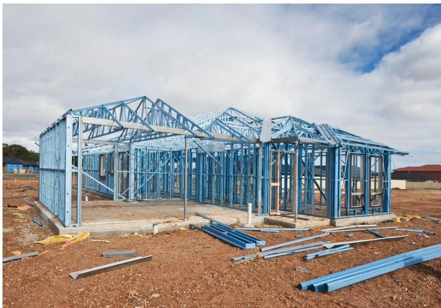
Figura 15. Construção em Steel frame.
