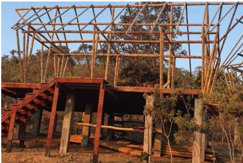
Figura 20. Uso de bambu na construção civil.
