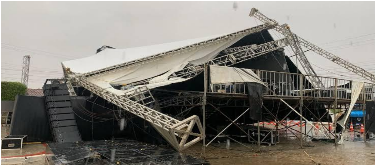
Figura 1. Palco Desaba no Interior da Bahia.
