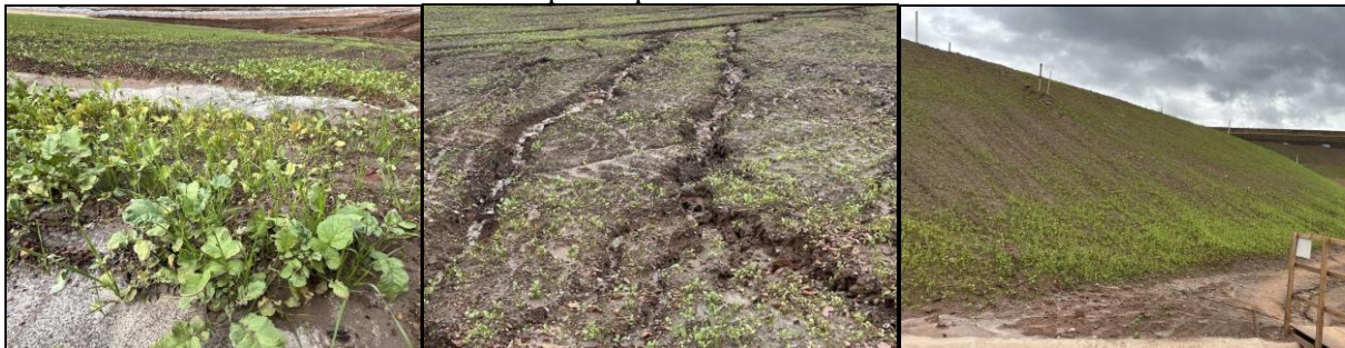
Figura 2. Resultado da germinação após a primeira aplicação de hidrossemeadura, presença de ravinamento e carreamento das sementes para a parte inferior dos taludes.
