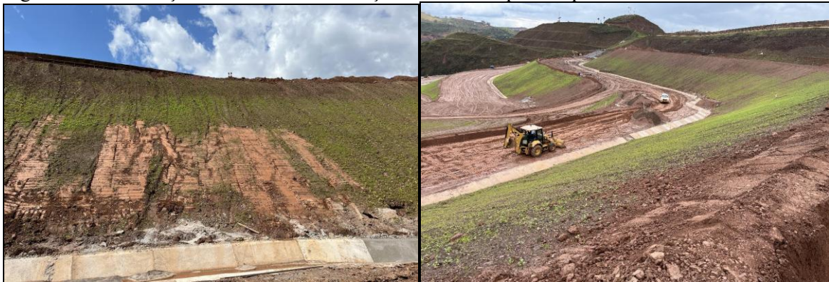
Figura 3. Conformação das ravinas e confecção de leiras na parte superior dos taludes
