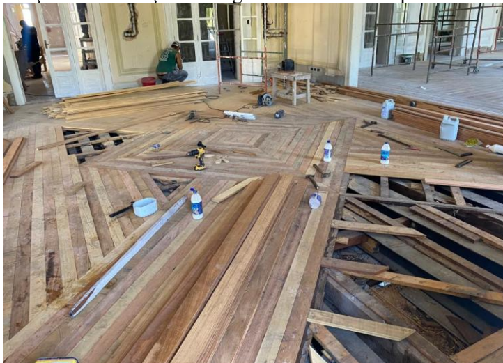
Figura 1. Remoção e reinstalação das régua de madeira em piso histórico.
