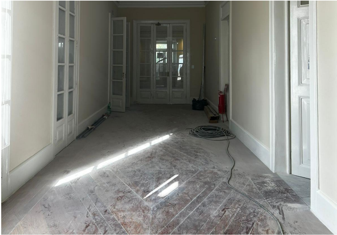
Figura 2. Execução de restauro no piso de madeira, com manutenção do padrão original de assentamento.
