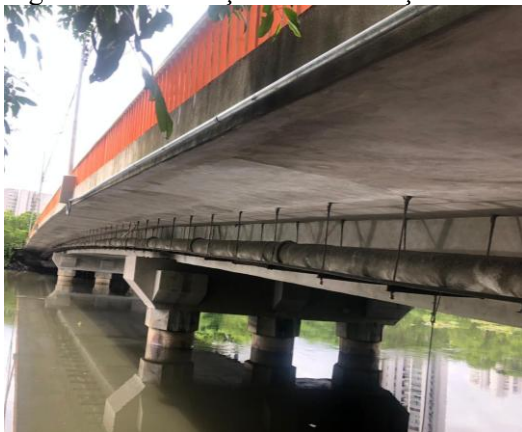
Figura 2. Intervenção de reabilitação estrutural concluída.
