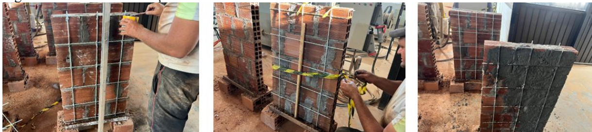
Figura 1. Processo de reforço das alvenarias com o uso de telas de fibra de vidro.
