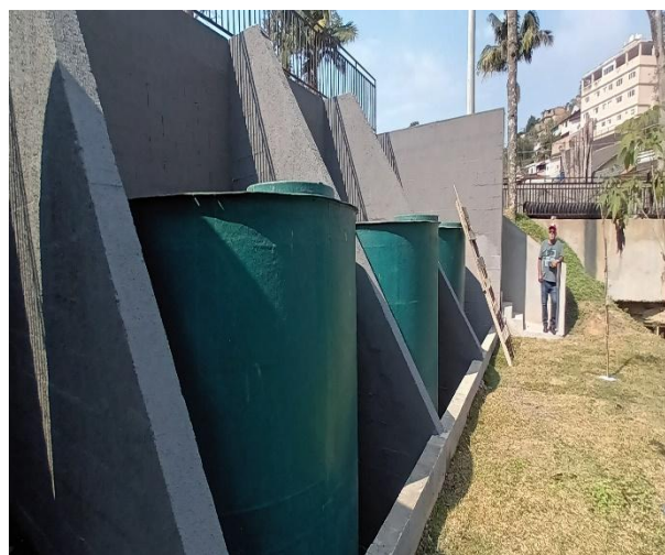
Figura 7 :Instalações do Reator Anaerobio Avançado Aéreo, em fibra de vidro , apoiado sobre o solo
