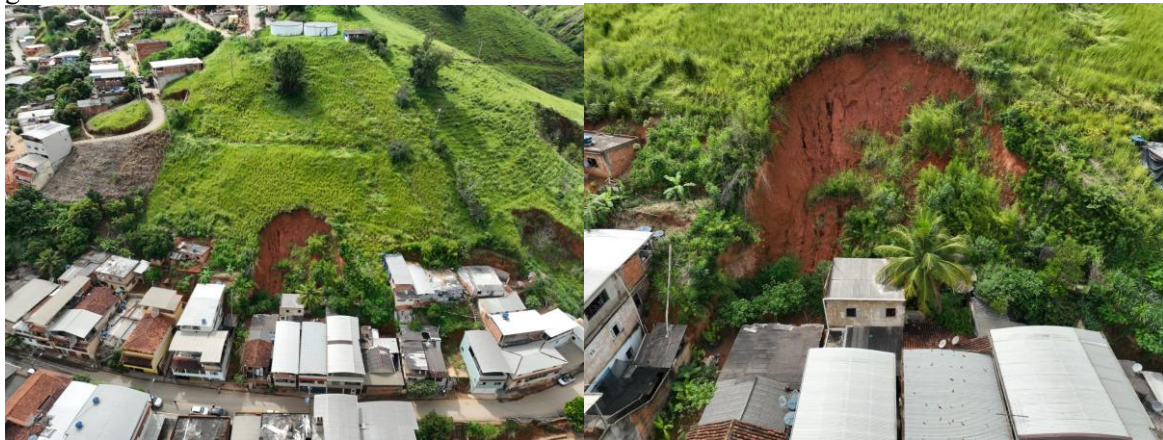
Figura 3. Cicatriz de deslizamento em talude na vila do sul.
