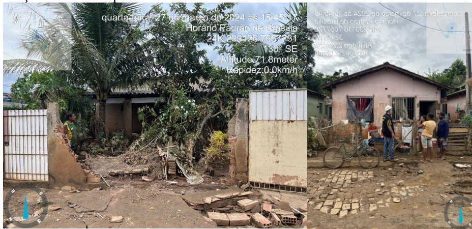
Figura 5. Situação das casas após as chuvas.
