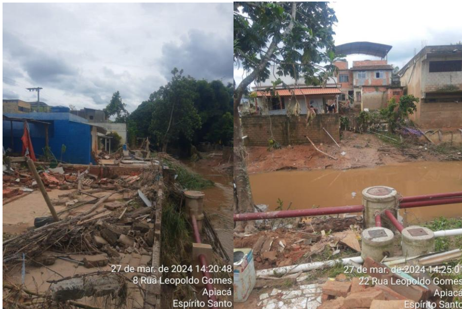
Figura 3. Situação das casas na Rua Leopoldo Gomes, localizadas à margem do rio.
