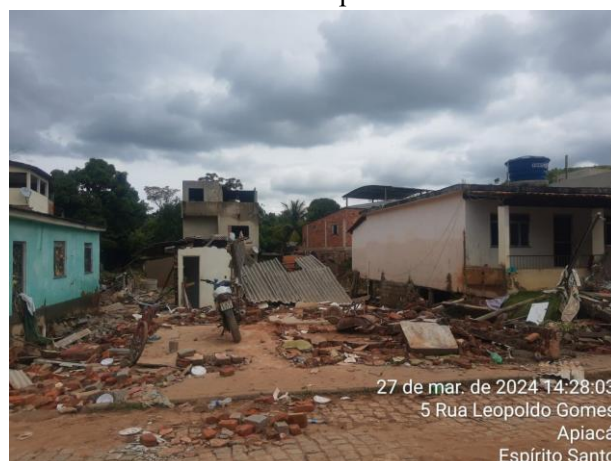
Figura 2. Residência totalmente destruída na Rua Leopoldo Gomes.
