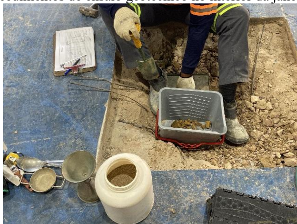
Figura 2: Procedimentos de ensaio geotécnico no interior da janela de inspeção.
