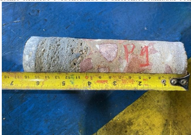
Figura 1: Testemunho extraído evidenciando as diferentes camadas constituintes do piso.
