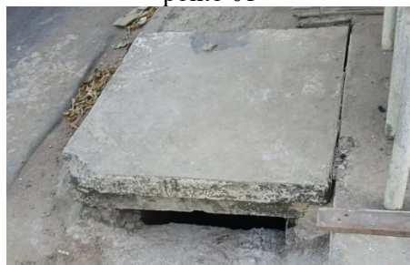
Figura 5 – Condições gerais da boca de lobo no ponto 01
