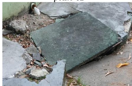
Figura 6 – Condições gerais da boca de lobo no ponto 02
