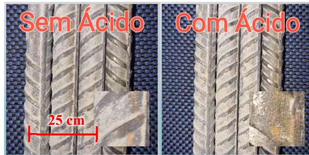
Figura 2: Análise de Corrosão na Barra de Aço
