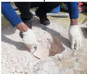
Figura 4 – Escavação e limpeza.
