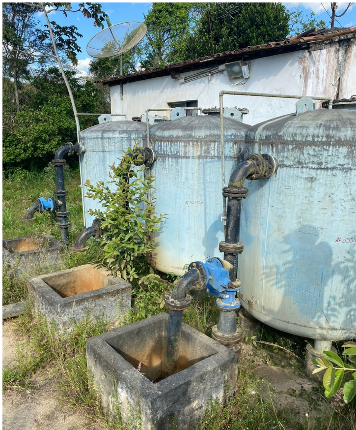
Figura 3- Estação de Tratamento de Água de Orobó- PE
