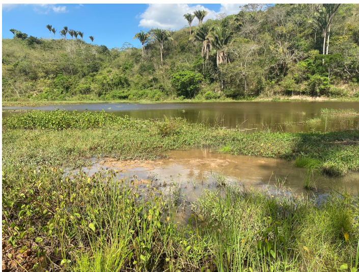
Figura 2- Barragem do Escuro
