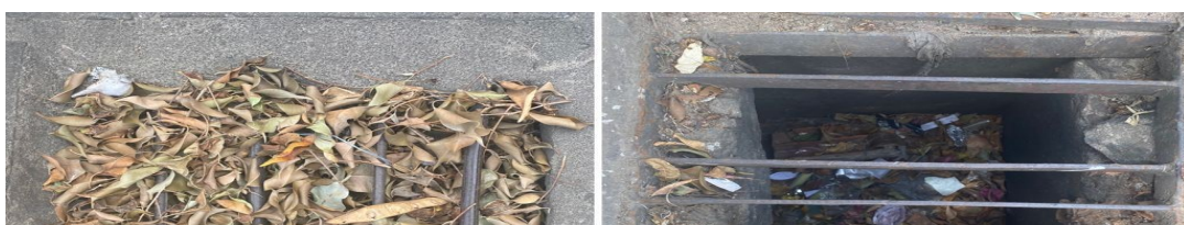
Figura 5 – Bocas de lobo da zona urbana
