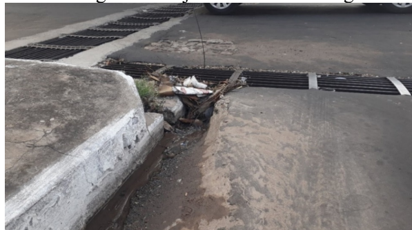
Figura 9. Sarjeta e canaleta com grade
