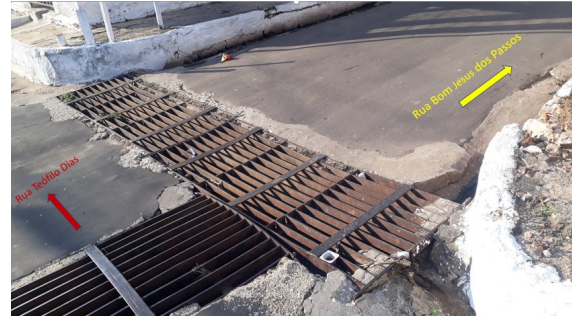
Figura 5. Canaleta com grade no sentido transversal da Rua Bom Jesus dos Passos.
