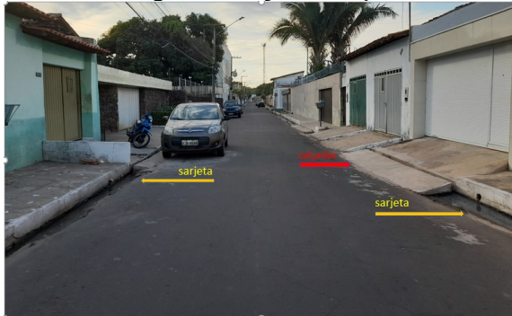
Figura 6. Sarjeta e calçada.
