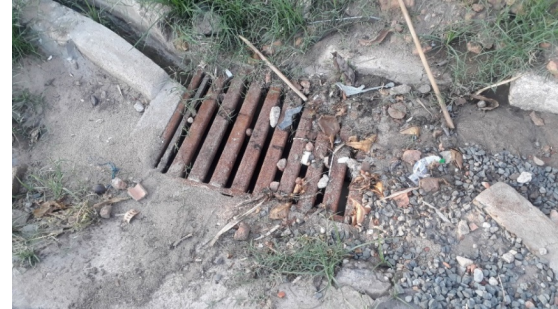
Figura 3. Boca de lobo do tipo grelha.
