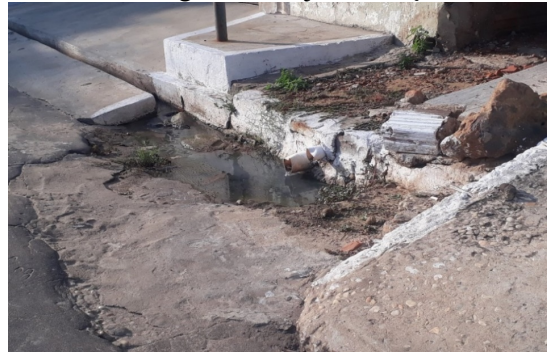
Figura 7. Sarjeta e calçada.
