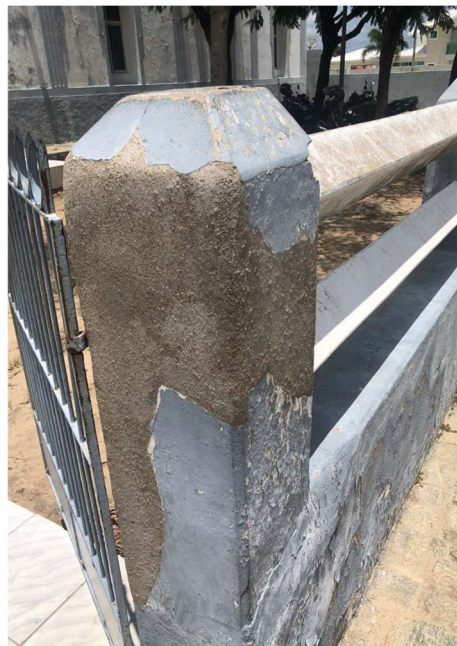
Figura 9. Revestimento Argamassado refeito
