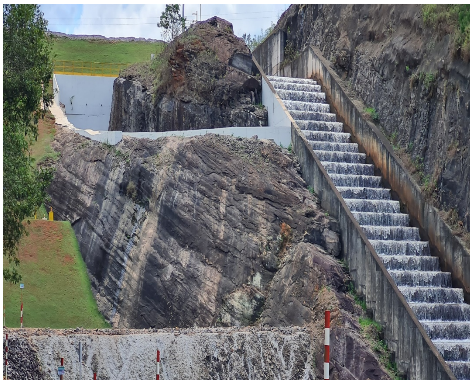
Figura 1 – Vista frontal Barragem do Diogo – Mina de água limpa, Rio Piracicaba/MG
