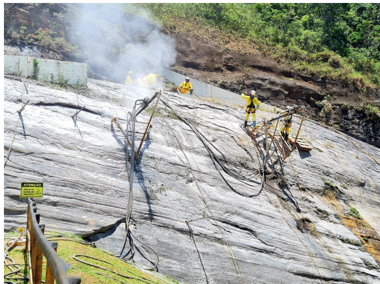
Figura 4 – Execução dos tirantes em rapel
