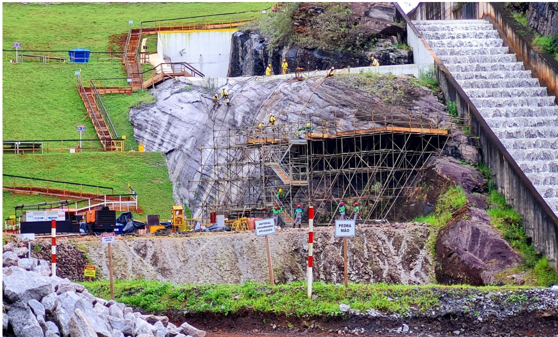
Figura 6 – Execução dos tirantes em andaimes
