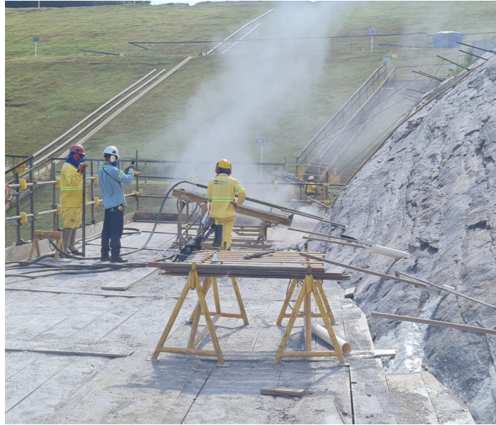
Figura 7 – Execução dos tirantes em plataforma de andaime
