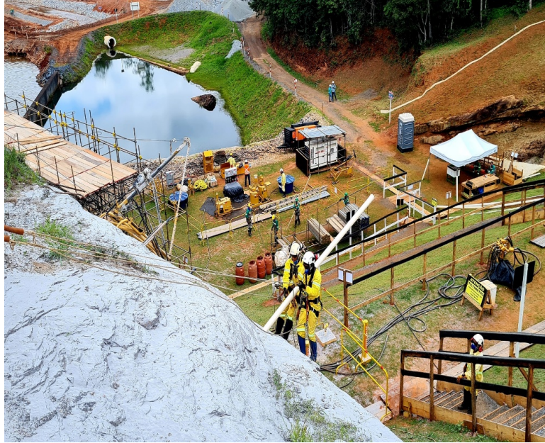
Figura 5 – Execução dos tirantes
