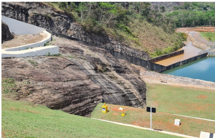
Figura 2 Talude rochoso a jusante da Barragem do Diogo
