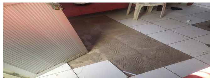
Figura 4 – Destacamentos cerâmicos
