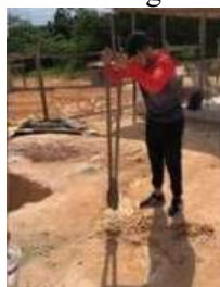
Figura 5 – Escavação da cova. Fonte: Imagem autoral.
