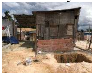
Figura 4 – Cova escavada no terreno. Fonte: Imagem autoral.
