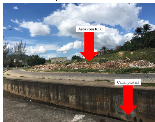
Figura 3 - Canal pluvial identificado nas proximidades da área com maior incidência de RCC no município de Guarabira-PB
