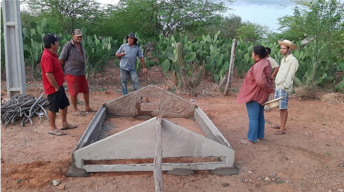
Figura 2. Construção do destilador solar.
