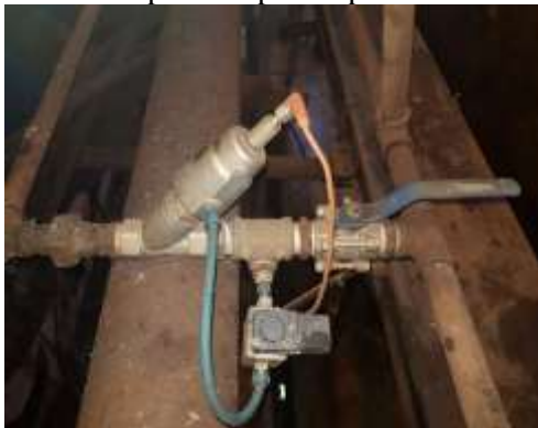
Figura 3 – Válvula Y on/off - Linha de ar comprimido para aspersores
