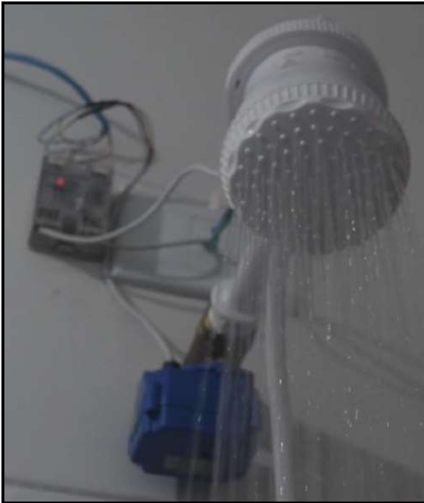
Figura 4. Teste em chuveiro exibindo o rele de estado sólido e a válvula motorizada.
