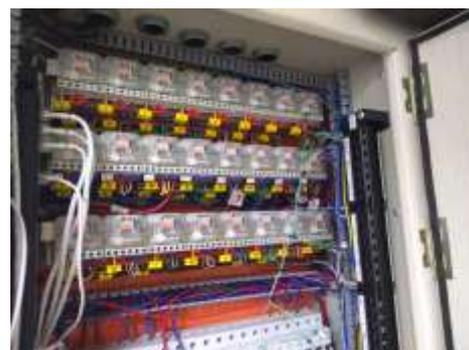
Sistema de acionamento dos circuitos de iluminação pelos relês de impulso
