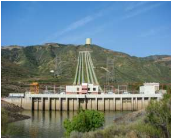
Fig. 5. Usina hidráulica reversível em Los Angeles, Califórnia.
