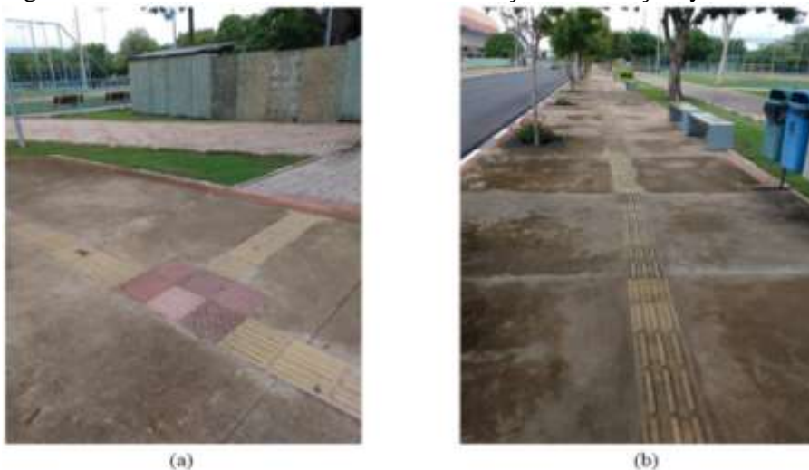
Figura 2. Piso tátil direcional e de alerta nas calçadas da Praça Ayrton Senna
