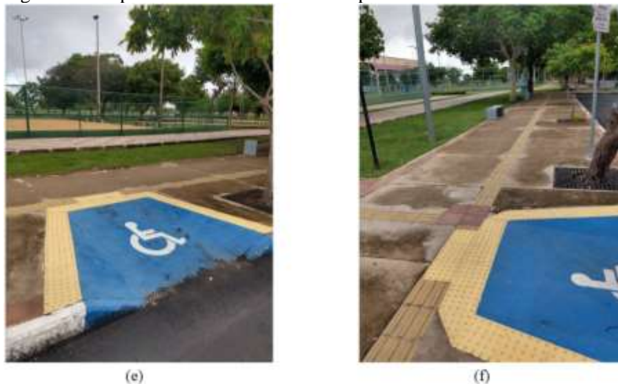
Figura 4. Rampas de acesso a cadeirantes e pisos táteis direcional e de alerta
