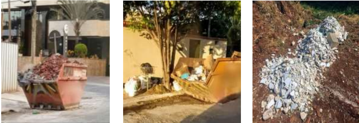
Figura 1: a) Resíduos sólidos da construção civil dispostos em caçambas no setor Oeste; b) Resíduos sólidos do setor Sul; c) Resíduos sólidos do Jardim Goiás: material cerâmico
