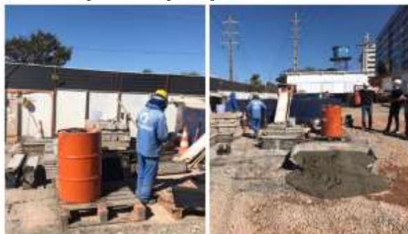
Figura 2. Uso das obras de concreto para a fabricação de meio fio e placas de proteção.
