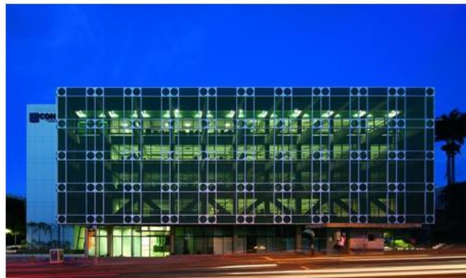
Obra é referência em engenharia e sustentabilidade
