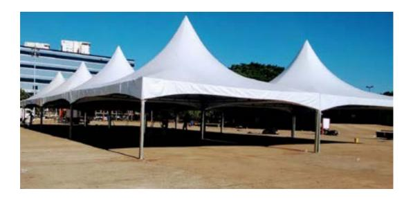
s tendas também são consideradas estruturas provisórias e, conforme o modelo, podem oferecer risco potencial de acidente. Os dois principais tipos de tendas existentes para comercialização são as do tipo sanfonada e piramidal.
